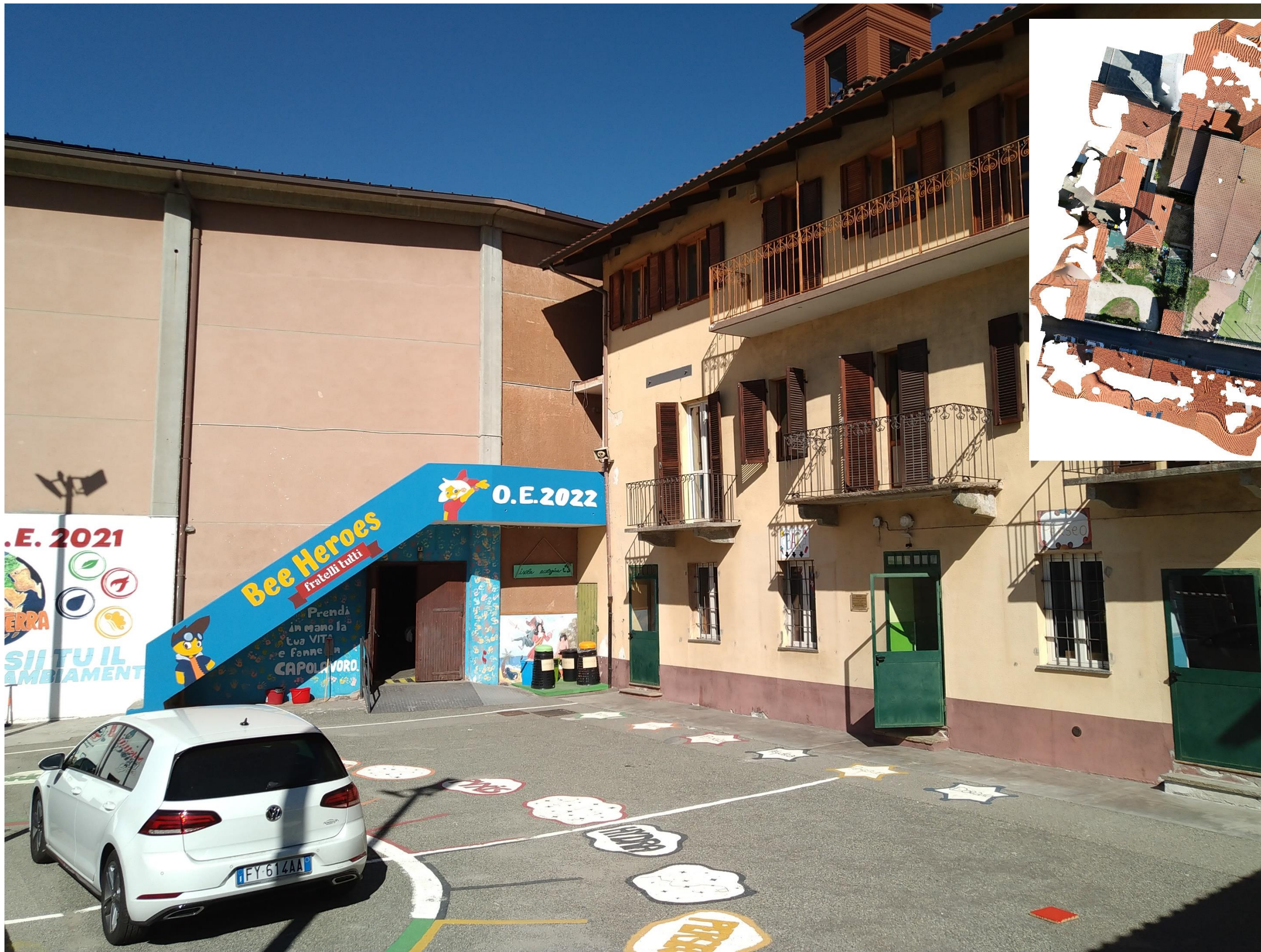
Foto interno piazzetta vista oratorio e ex-teatro
