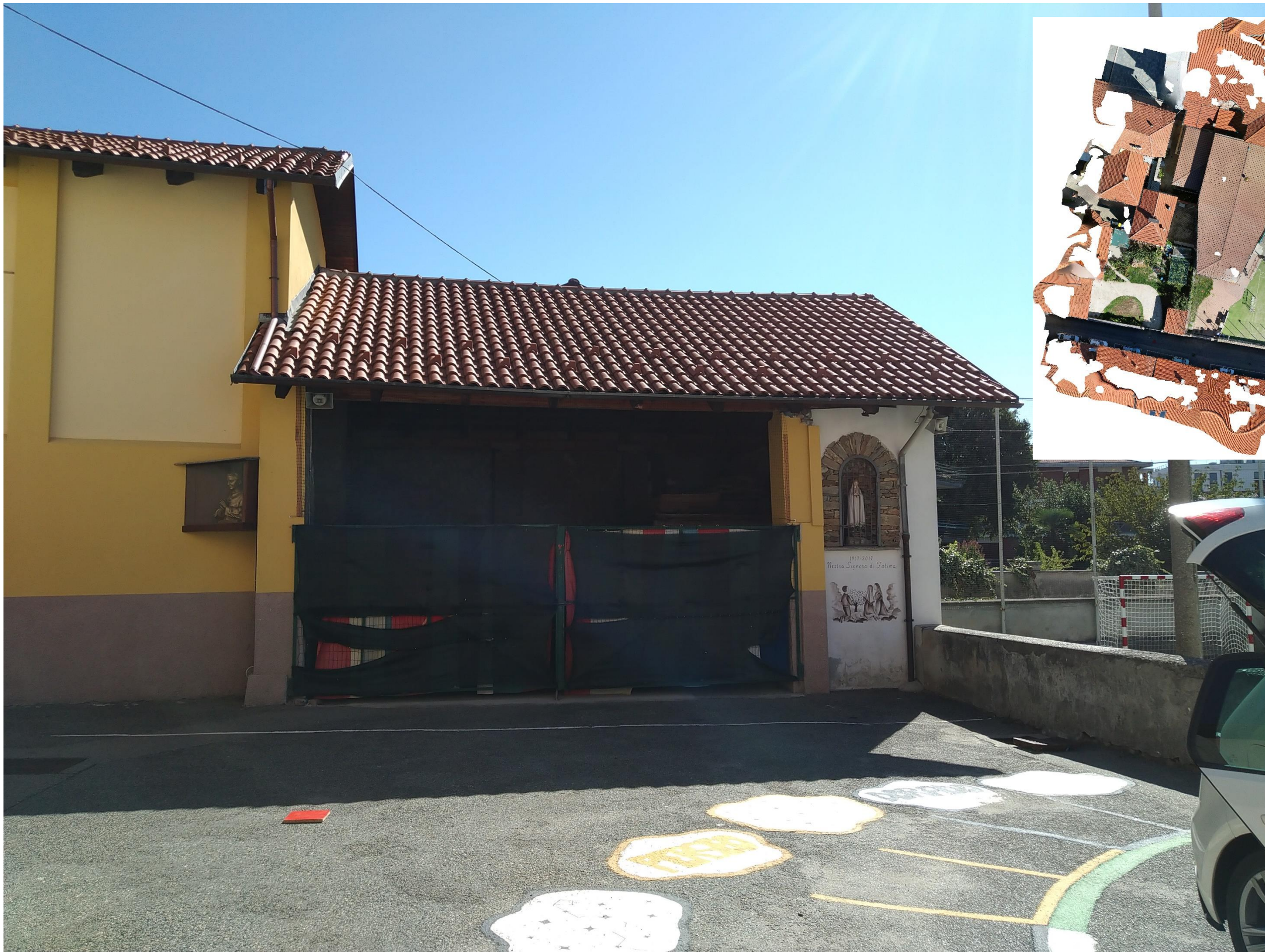
Foto interno piazzetta vista tettoia
