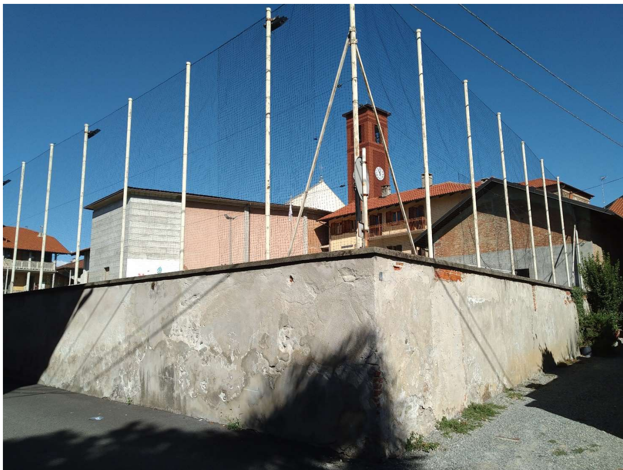
Figura 13 – Angolo tra Via San Sebastiano e Strada Privata prospetto est (Settembre 2022).
