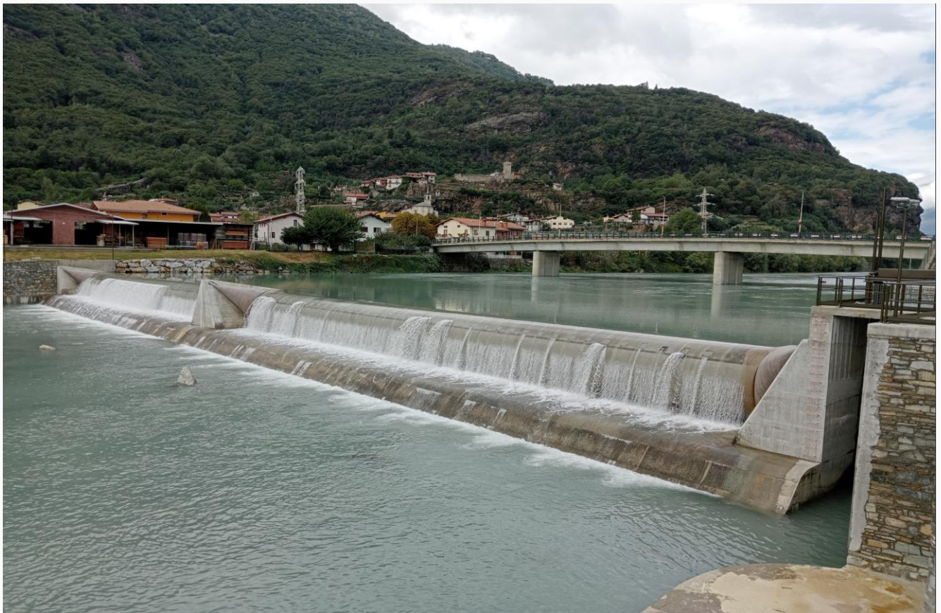
CENTRALE EDISON - QUASSOLO
