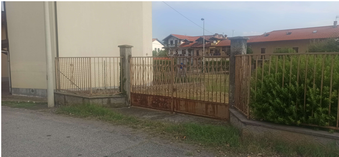
4. Primo tratto oggetto di intervento
